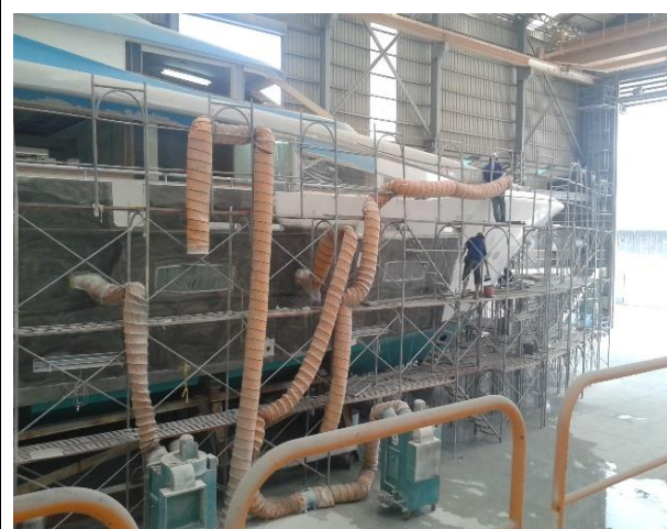
水磨於高空作業，具高度風險性，作業人員需長時間暴露於粉塵及水花噴濺的環境中
